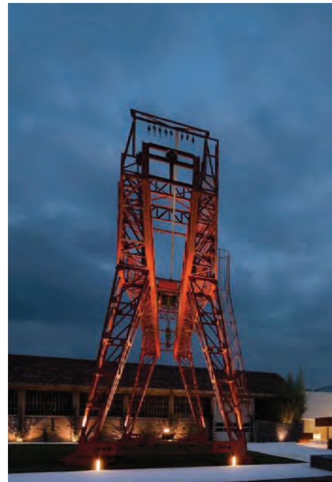
Atelier EERA Verona, Italia Architetti: Qui(E)T Architecture
