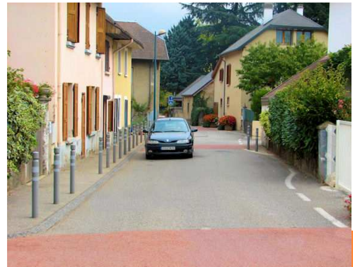
Segnalazione a raso delle traverse
